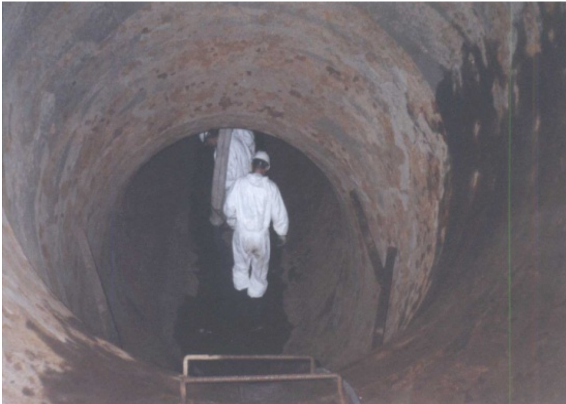
Rys. 4-17. Rurociąg zrzutowy Elektrowni Bełchatów i pracownicy Katedry podczas inspekcji korozyjnej
